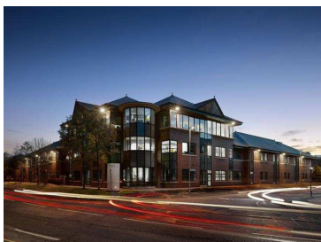
Obrázek č. 5: Pohled na VTP
