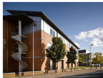
Obrázek č. 7: Budova VTP
